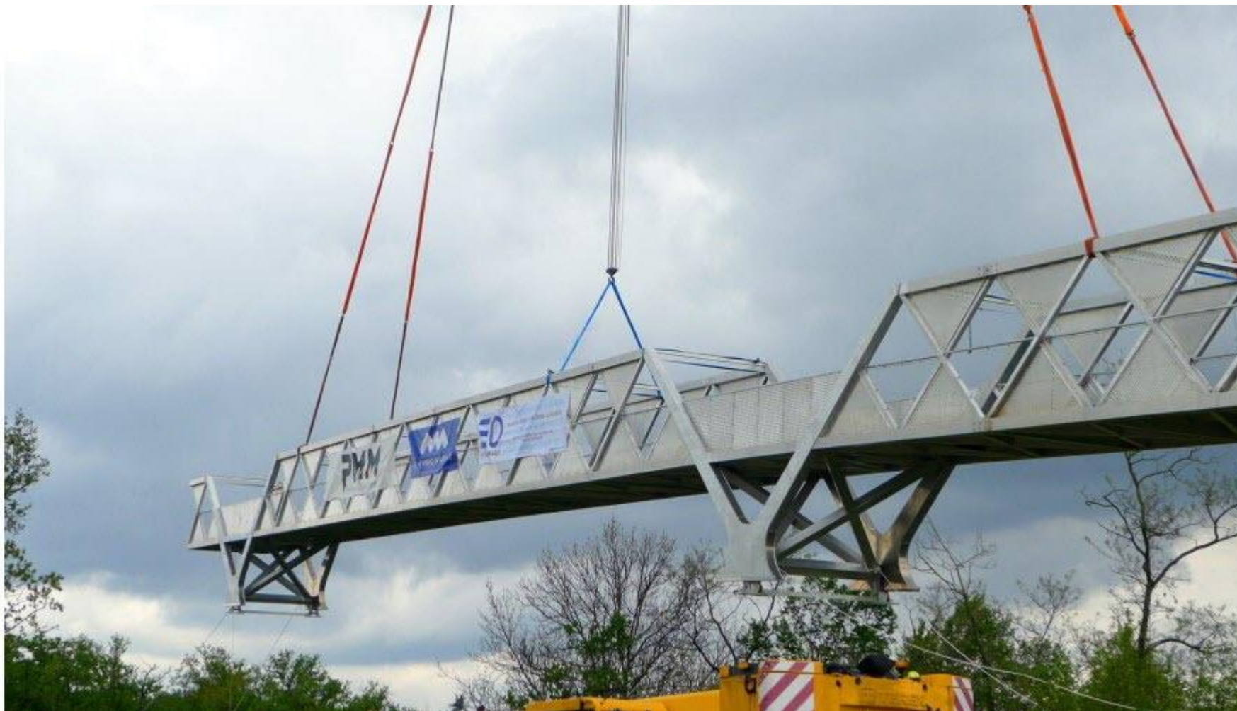
La passerelle aluminium pèse 24,4 tonnes. (Photo Thierry Huot)
